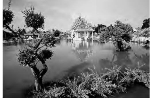
วัดกษัตราธิราชวรวิหาร สร้างกำแพงกันน้ำ ล้อมรอบแต่ยังมีน้ำซึมเข้ามาอย่างที่เห็น
