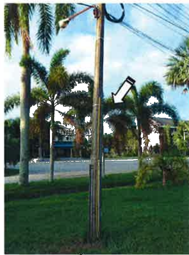
การติดตั้งสาย Ground
